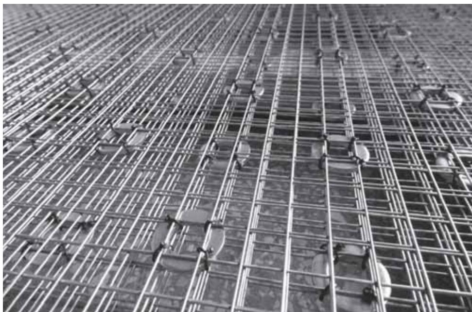
Рис. 1 – Арматурні сітки плити
