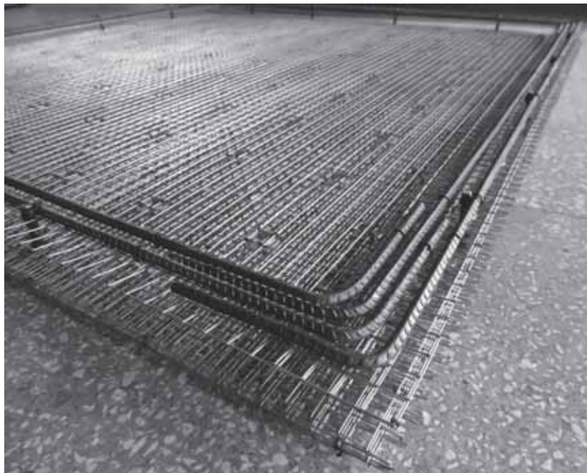
Рис. 2 – Армування ребер жорсткості плити
