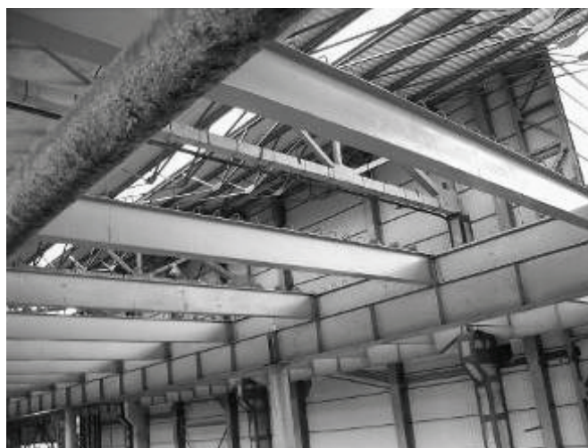
Рисунок 6 – Каркас виробничого корпусу ТОВ «АТЕМ» у м. Київ під час монтажу
