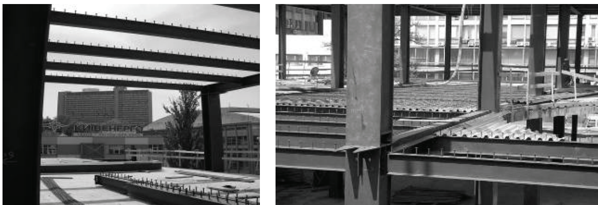
Рисунок 5 – Каркас торгово-офісного комплексу з паркінгами у м. Київ під час монтажу
